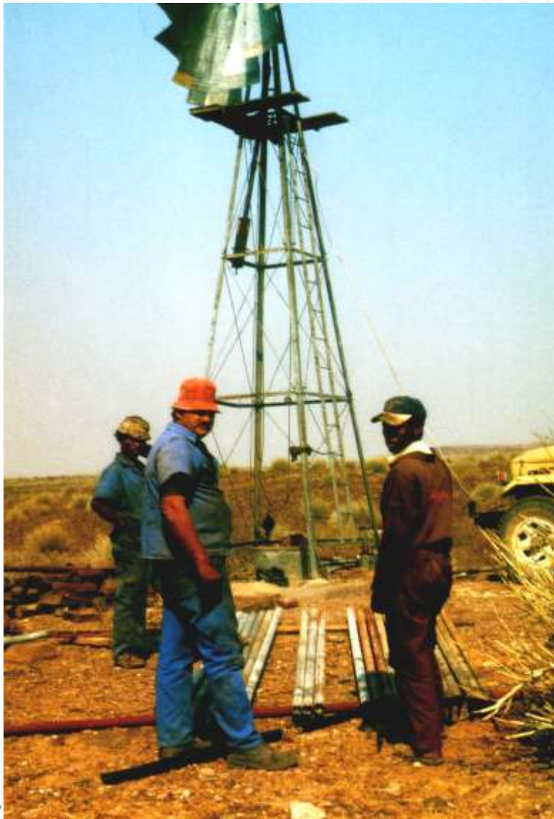
Der Bure Schalk Liebenberg, Nachbar des Canyon Nature Park Namibia auf der Grenzfarm Churutabis und im ersten Versuchsjahr ab 1997 der Erste Vormann im CNP, mit zwei selbständigen Kontraktarbeitern (Namaleute) bei der Erneuerung von Förderrohren an einer alten Windpumpe, die zur Versorgung einer Wildtränke umgerüstet wird. - "Gentlemanfarmer"? (Vergeleë im CNP, Windpumpe V5 "Swartplaat", 1997)
