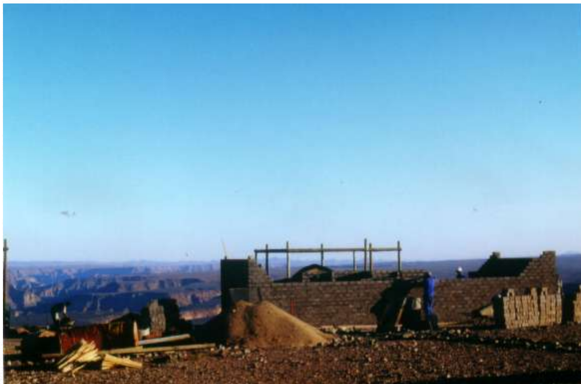
Bauarbeiten mit Zementziegeln aus Eigenproduktion und natürlichen Klippen aus der Umgebung an einem Gästebungalow der "Lodge mit Canyonblick - Canyon View Camp". - Integration von Wildhaltung, Touristik und Partizipation der regionalen Bevölkerung durch Existenzgründungsförderung. (Canyon View Camp im CNP, 1999)
