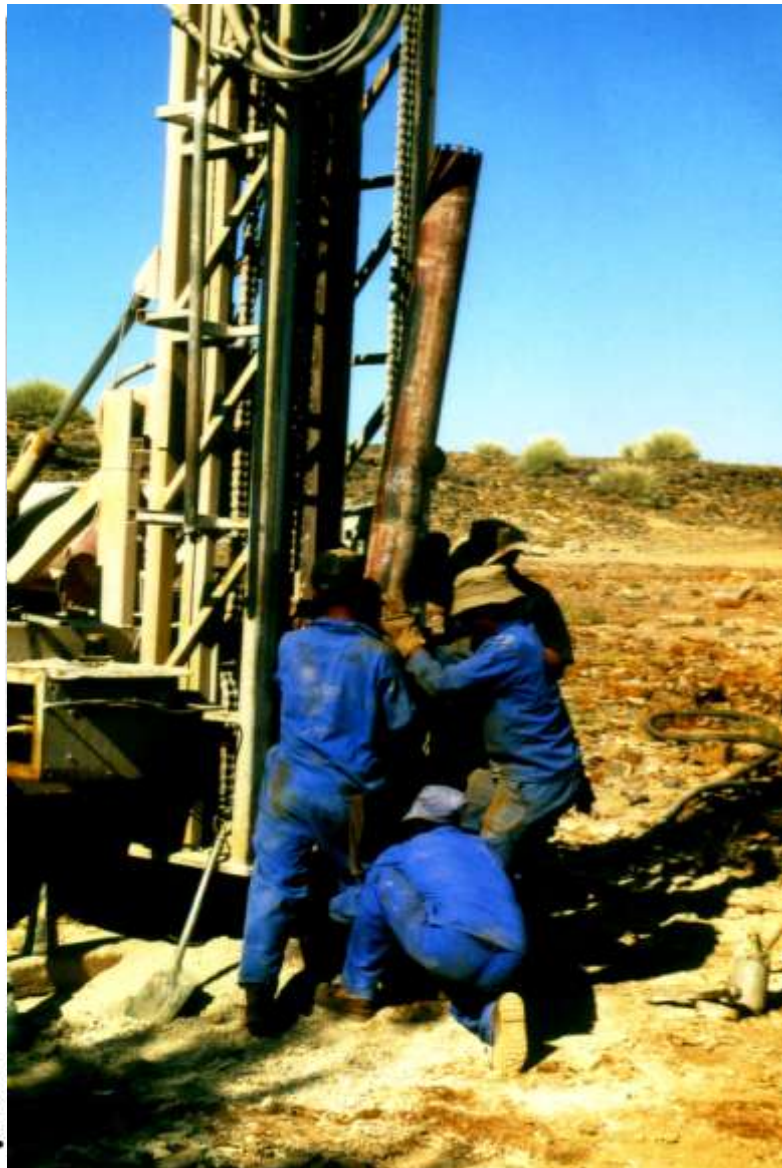
Denkmal für die Helden der Arbeit im Großen Namaland? - Die ersten Meter sind lockeres Flußsediment: einsetzen eines Futterrohres in das Bohrloch. (Soutkuilrivier am Anwesen Soutkuil im CNP, 1997)
